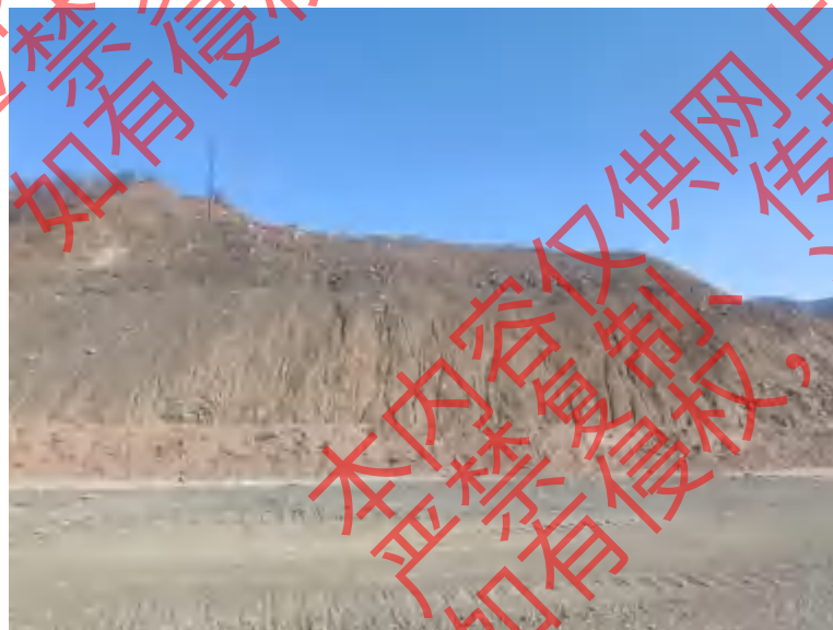
1156m至1159m标高错车道路面宽度不符合设计要求
