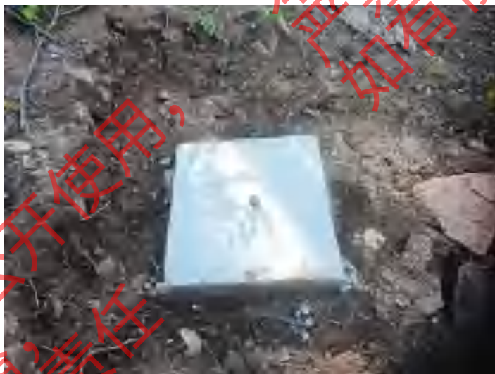
已按设计要求在采场西侧增加人工位移监测点
